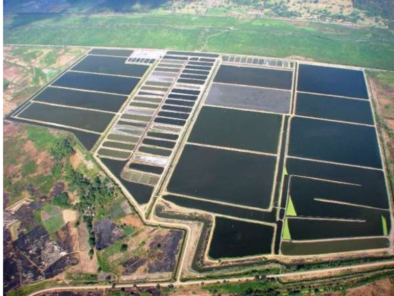
Imagen No. 30: Finca productora de tilapia con sistema de recirculación de agua al 100%. Propiedad de Modercorp S.A. – Taura, Ecuador.
