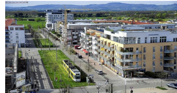
Imagen 38: Sistema de transporte Tranvía del Barrio de Rieselfeld
