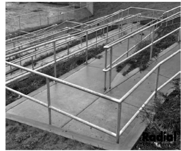
Imagen 33. Rampa o circulación inclinada Fuente: Radial, s.f.
