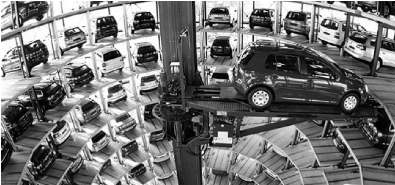
Imagen 39. Estacionamiento automático por plataforma Fuente: ARQHYS, s.f.
