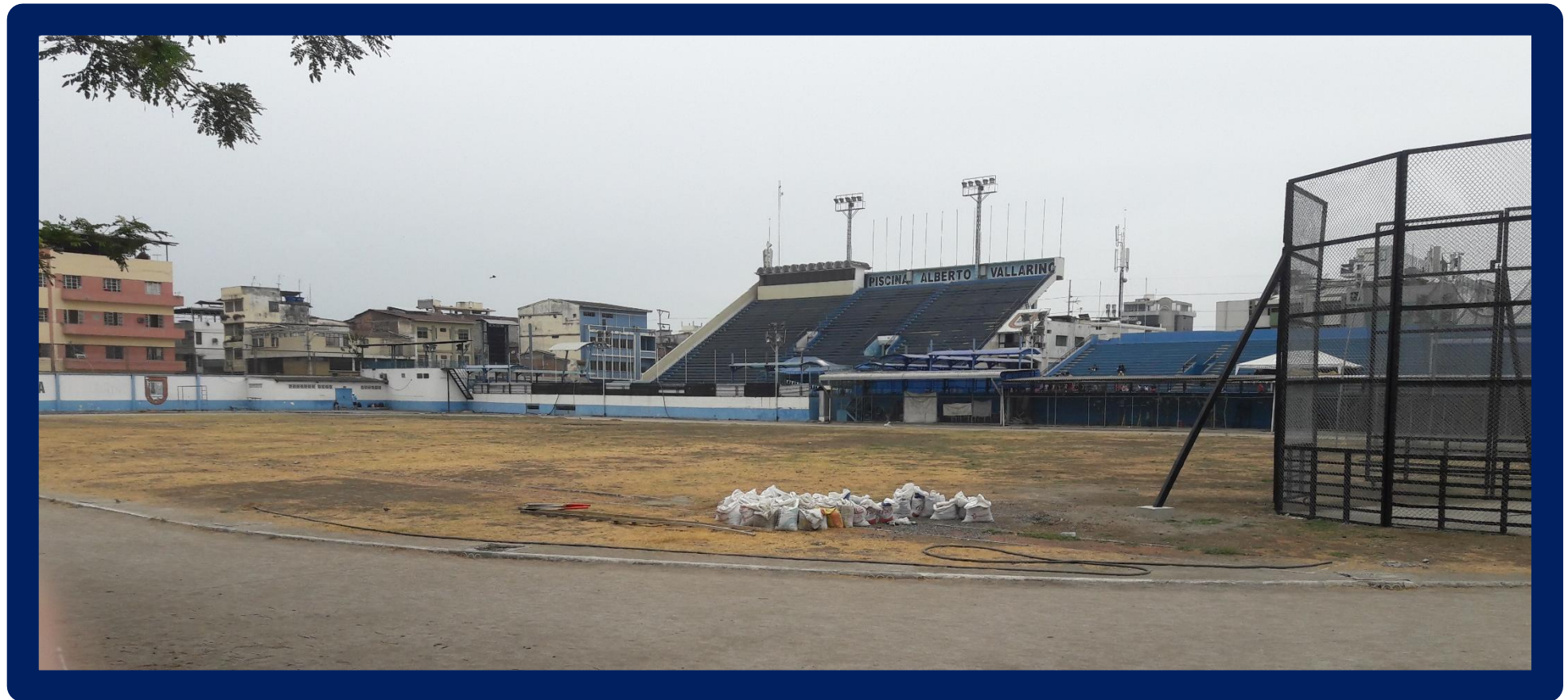
Imagen 46: La pista de atletismo del complejo de piscina Garay Vallarino
