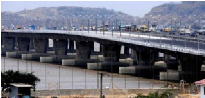
Imagen #17: Puente de la Unidad Nacional Rafael Mendoza Avilés Fuente: Ecuapana
