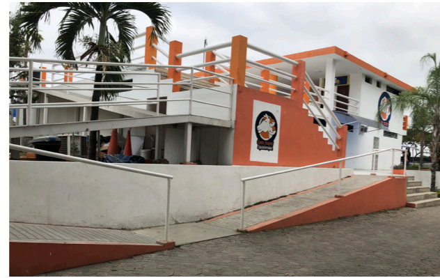
Figura 63. Edificio principal Sector B. Fuente: Elaboración propia.
