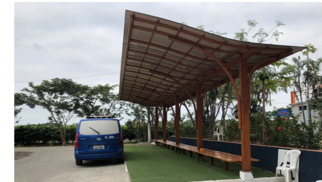
Figura 60. Paradero Sector B. Fuente: Elaboración propia.
