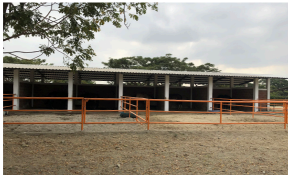
Figura 52. Caballeriza Sector A. Fuente: Elaboración propia.
