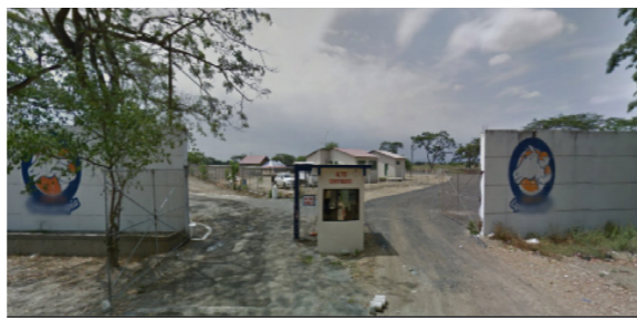
Figura 51. Garita Sector A. Fuente: Elaboración propia.
