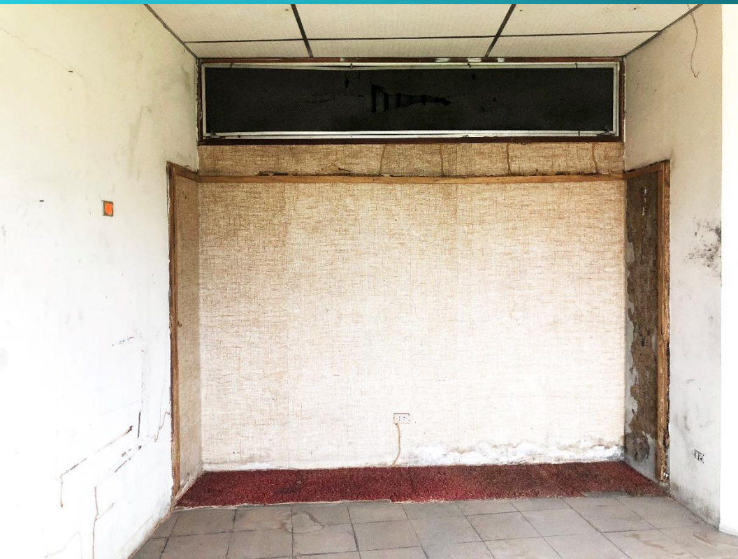
Imagen 6. Residencias dentro de Coliseo Voltaire Paladines Polo. Fuente: Elaboración propia (2018).
