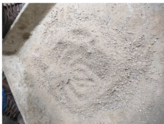
Figura 3. 15 mezclado en seco tierra, cal y fibra de vidrio
