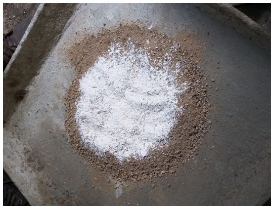
Figura 3. 13 Mezclado en seco tierra y cal
