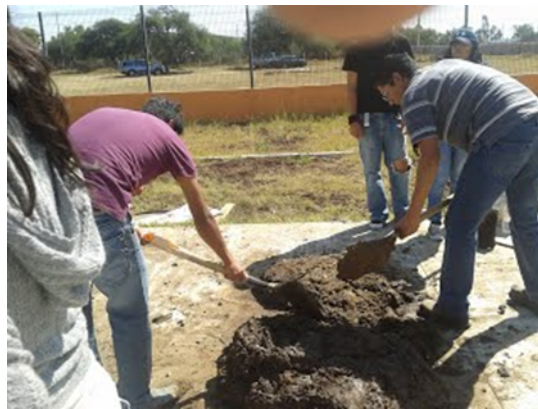
Figura 2. 12 Proceso de mezclado de materiales secos para adobe.
