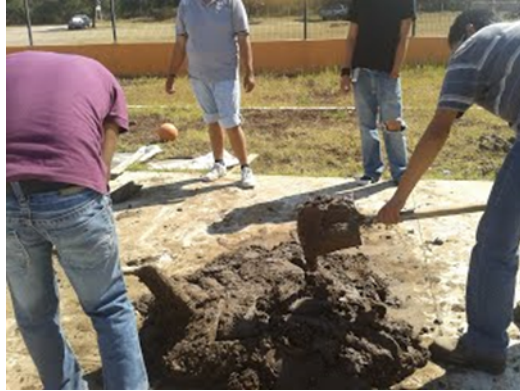
Figura 2. 13 Mezcla de materiales secos con agua para elaboración del adobe.
