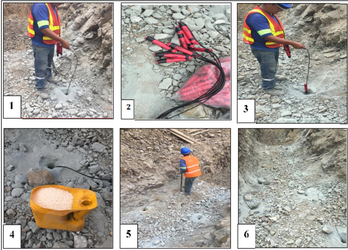
**Figura 2.9** Proceso de carga de explosivos en barrenos
