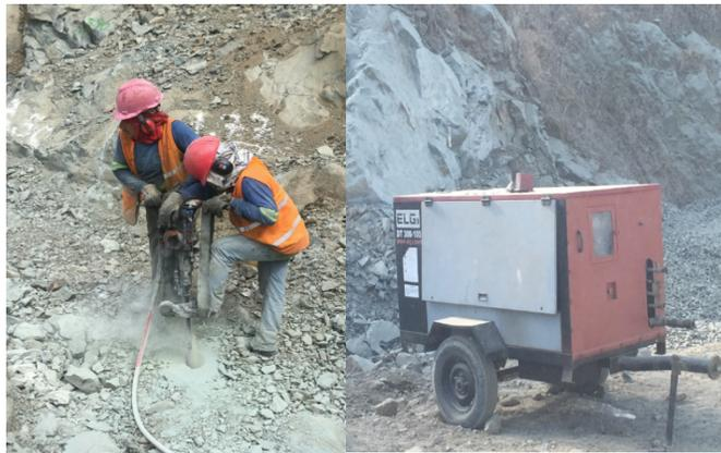
**Figura 2.8** Equipo acoplado a compresor de aire para perforación manual de barreno: a) Martillo, b) Compresor de aire ELGI-300
