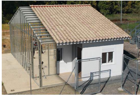
Fig 5. Casa Steel Frame.
