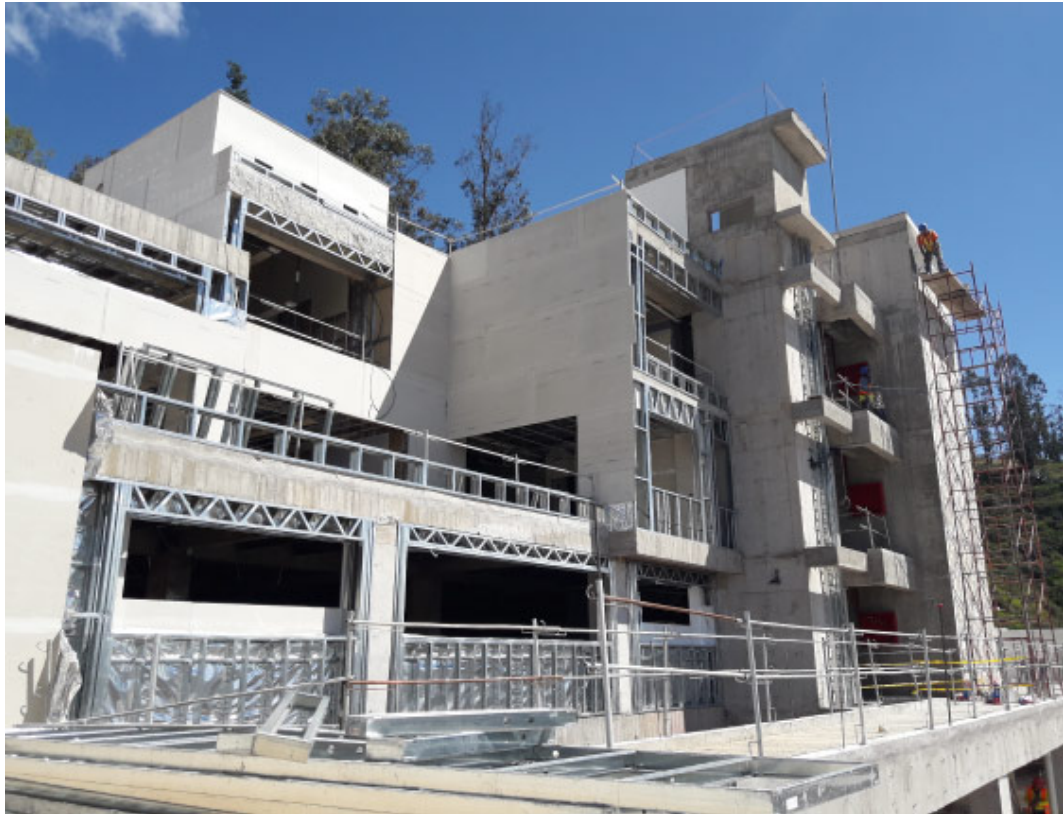
Edificación con Steel Frame. Imagen Kubiec
