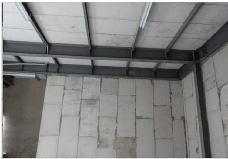
Losas Intermedias. Imagen Kubiec
