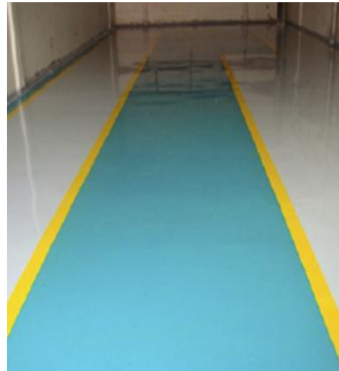
Recubrimiento de pintura epóxica en pisos
