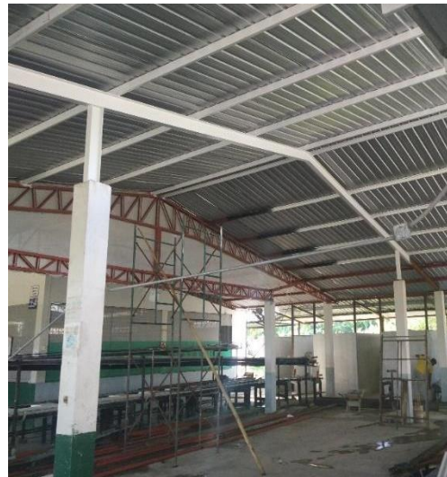
Restauración de cubiertas
