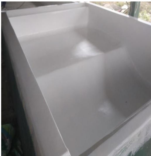
Tinas cubiertas de pintura epóxica
