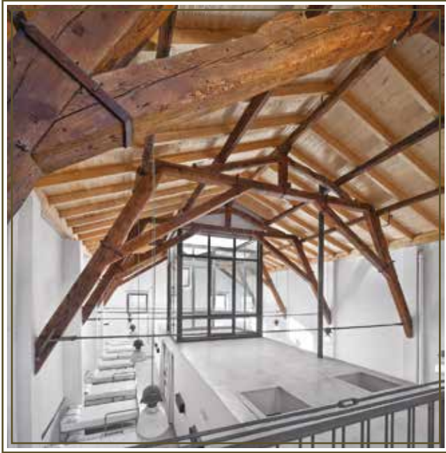
Imagen #16: Estructura visible en espacio de literas.
