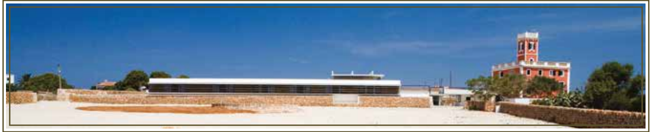
Imagen #26: Fachada horizontal Albergue Sa Vinyeta. Fuente: Jaime Sicilia, 2008.
