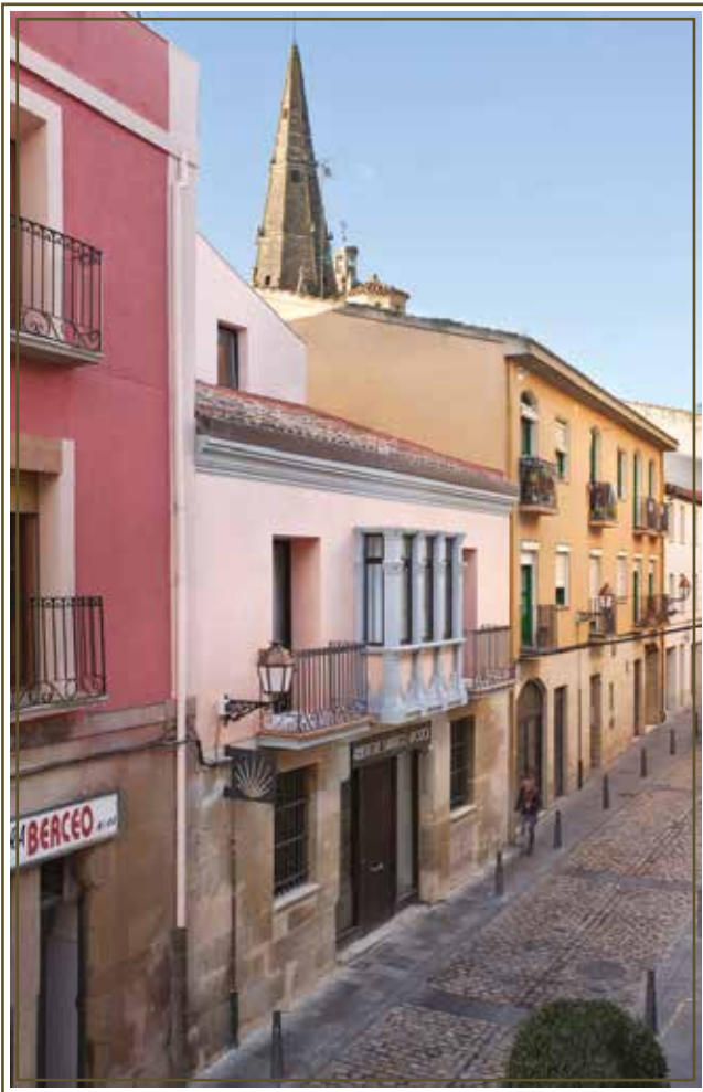
Imagen #18: Fachada Principal.
