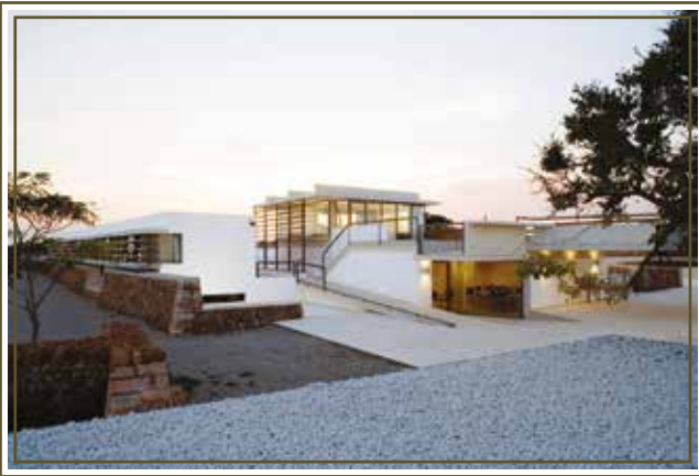
Imagen #23: Ingreso principal Albergue Sa Vinyeta.
