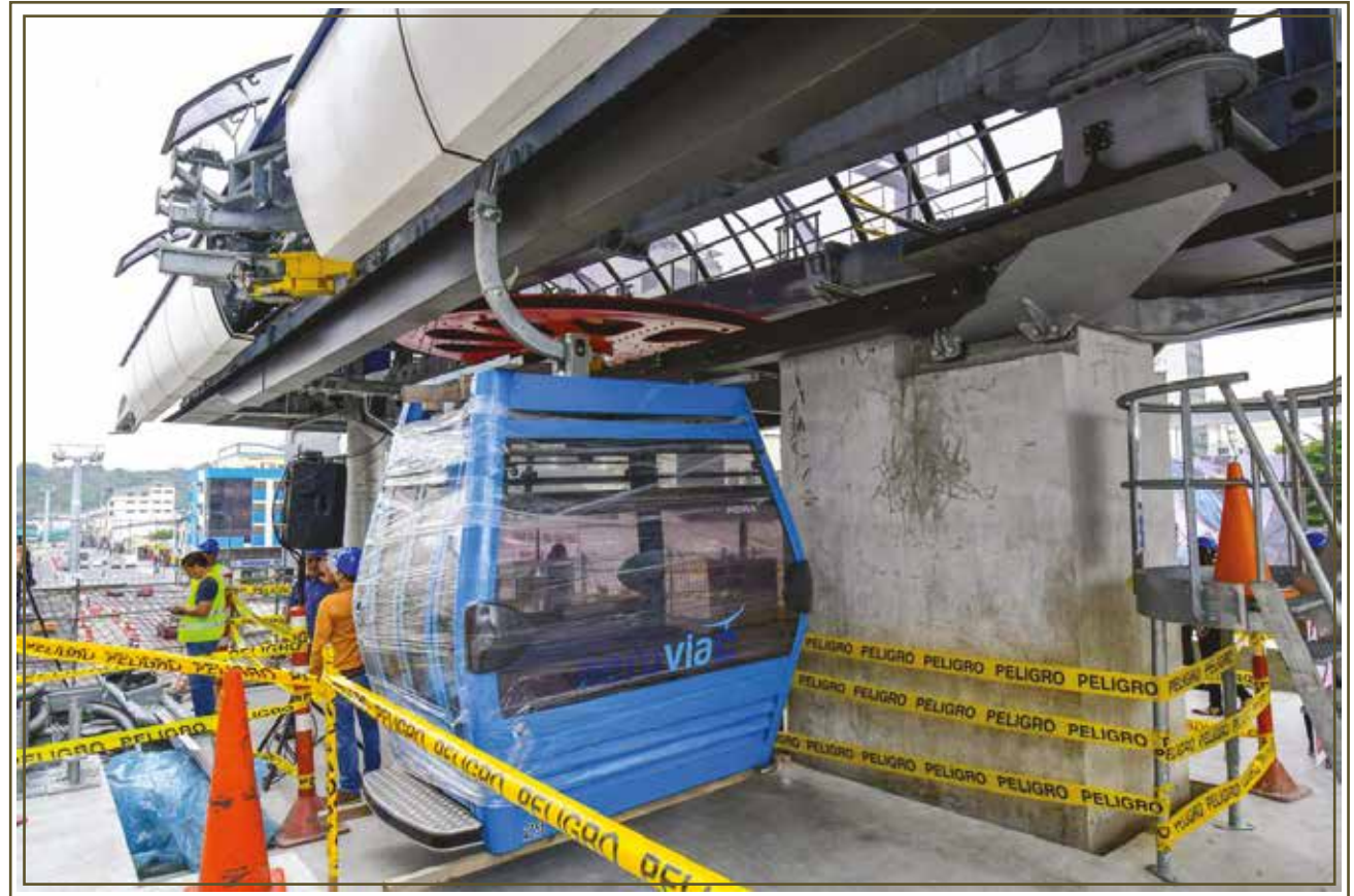
Imagen #57: Avances de la futura estación de aerovía. Estación 1 Parque Centenario.
