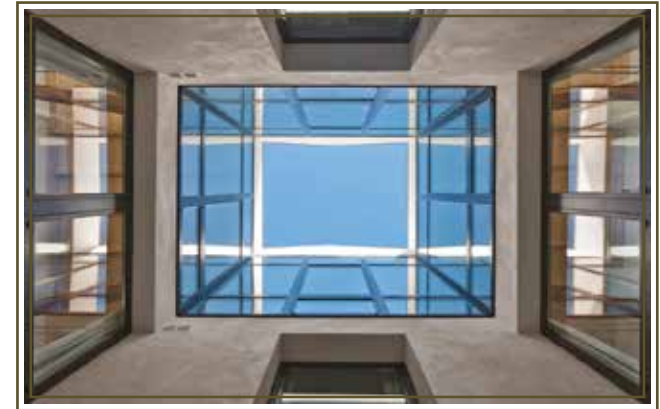
Imagen #19: Tragaluz en el centro de la edificación.
