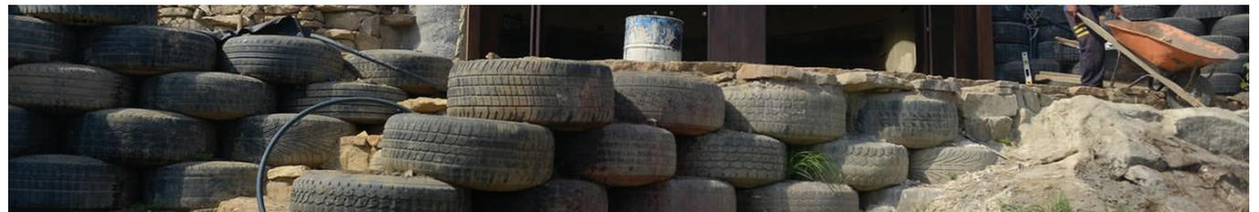
Imagen # 30 Casa con bases de neumáticos usados
