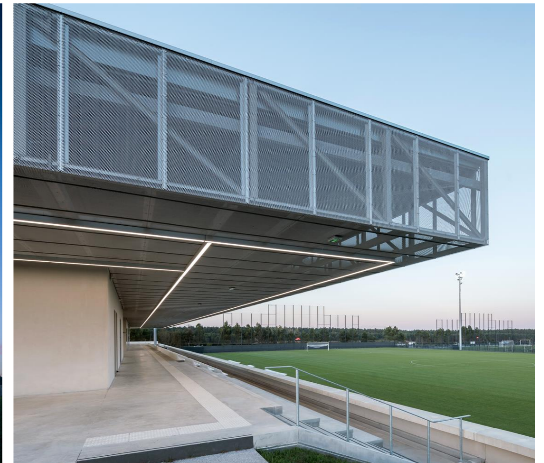
Figura #24. Vista en Perspectiva del Graderío de Plaine des Sports. Fuente: Stephane Aboudaram, 2020.
