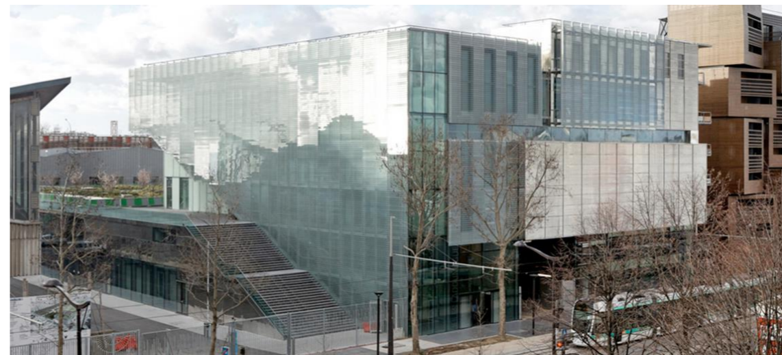
Figura #17. Vista en Perspectiva del Centro Deportivo Jules Ladoumegue. Fuente: David Boureau, 2014.
