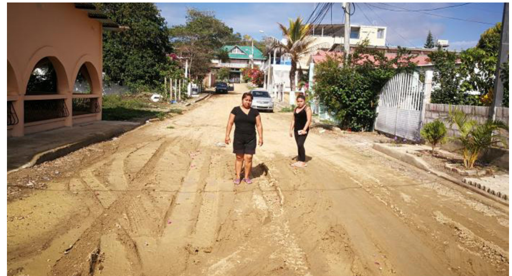
Imagen 7. Vía no pavimentada Fuente: (Néstor Mendoza, 2021)
