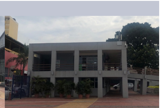
Imagen 44. Vista este volumen posterior Fuente: (Elaboración propia, 2021)
