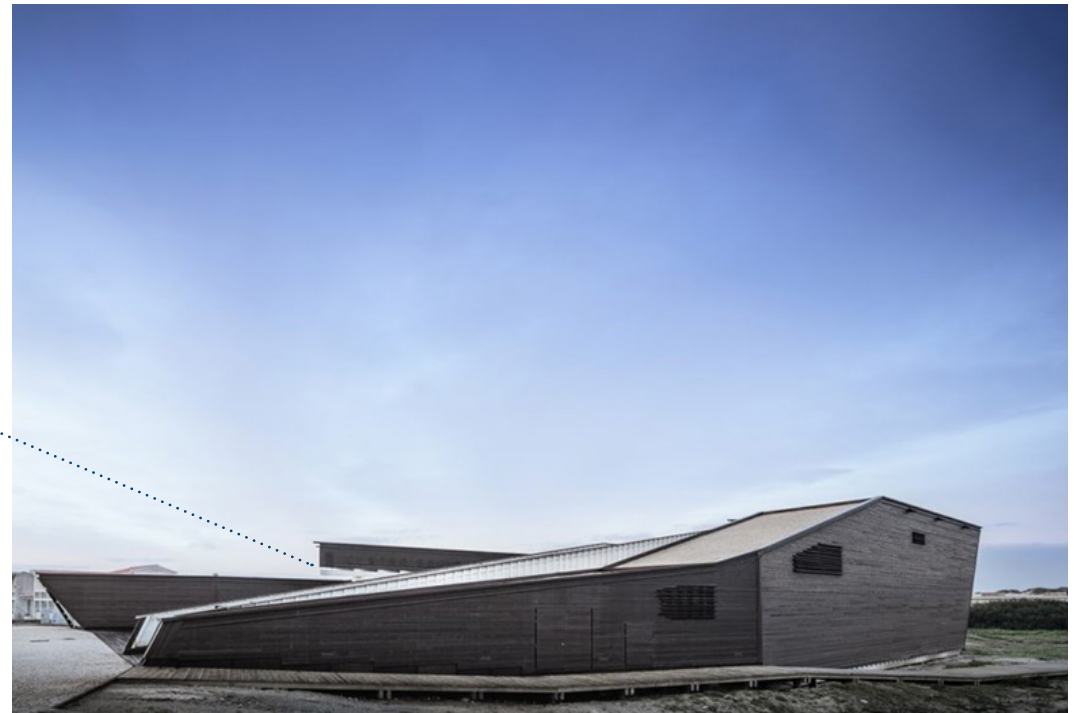
Imagen 32: Paneles de Aluacero utilizados en el proyecto. Fuente: Fernando Guerra, 2015 - Metaldesign, 2021.
