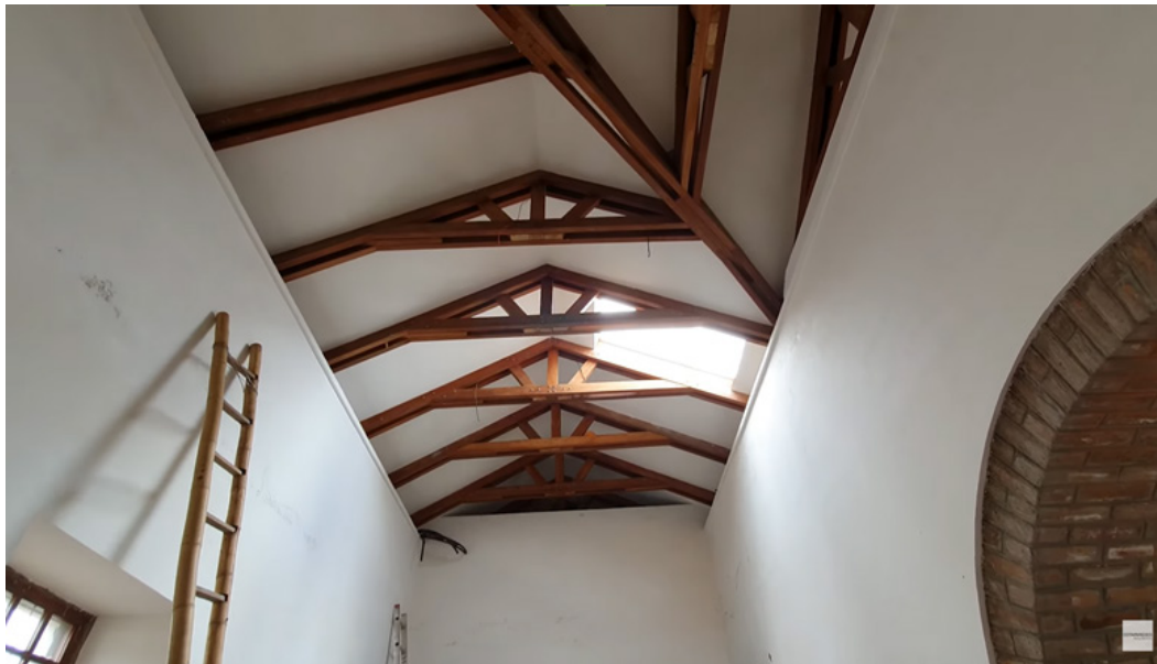
Imagen 14: Tragaluz en una de las naves laterales del proyecto. Fuente: Abraham Cota Paredes, 2019
