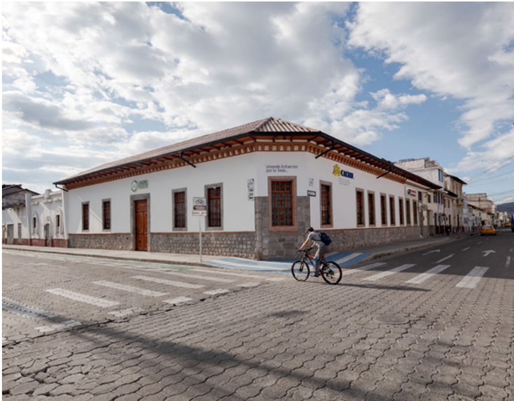
Imagen 6: CACMU Verde, Fachada frontal NE. Fuente: Bicubik, 2020
