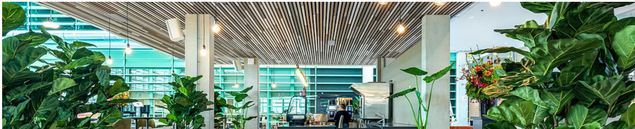
Imagen 46: Cielo de filtro Heartfelt - Control acústico Fuente: ArchDaily
