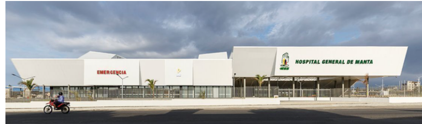
Figura 30. Fachada frontal del Hospital General de Manta Fuente. (PMMT, 2019)
