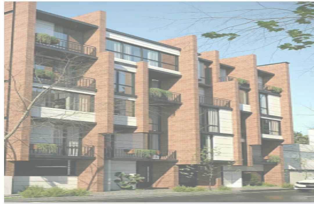
Figura 11. Edificio vivienda multifamiliar Fuente: (Arquimaster, 2021.)
