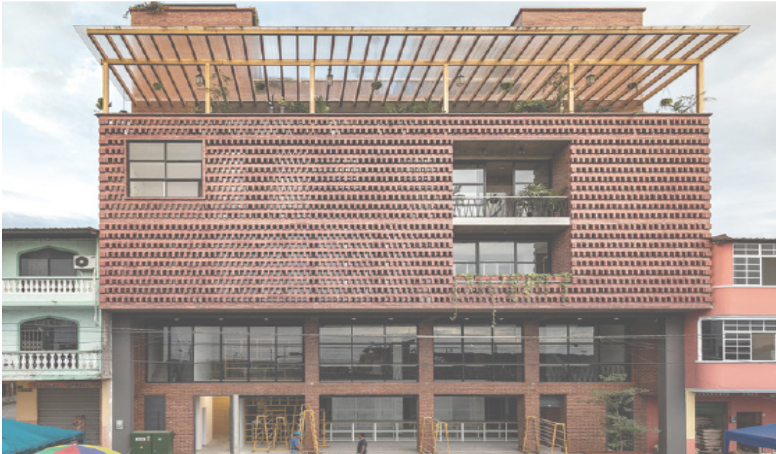
Figura 18. Fachada frontal, edificio Centro Productivo La Proveedora.
