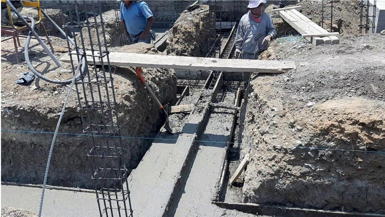
Imagen N°5 (Fundición de cimentación zapata corrida)
