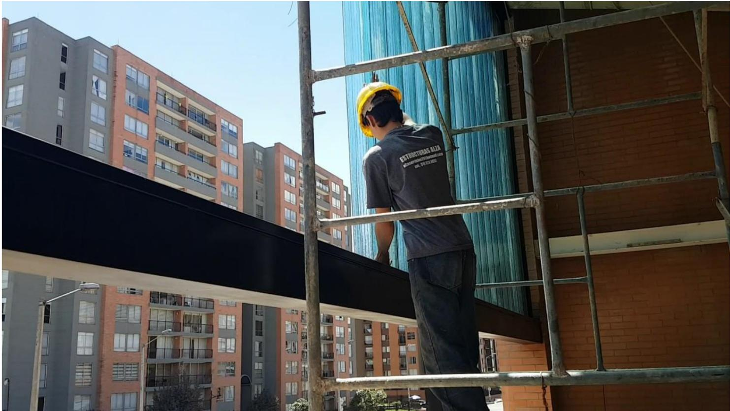
Imagen N°23 (Instalación de piel de vidrio sobre fachada principal)
