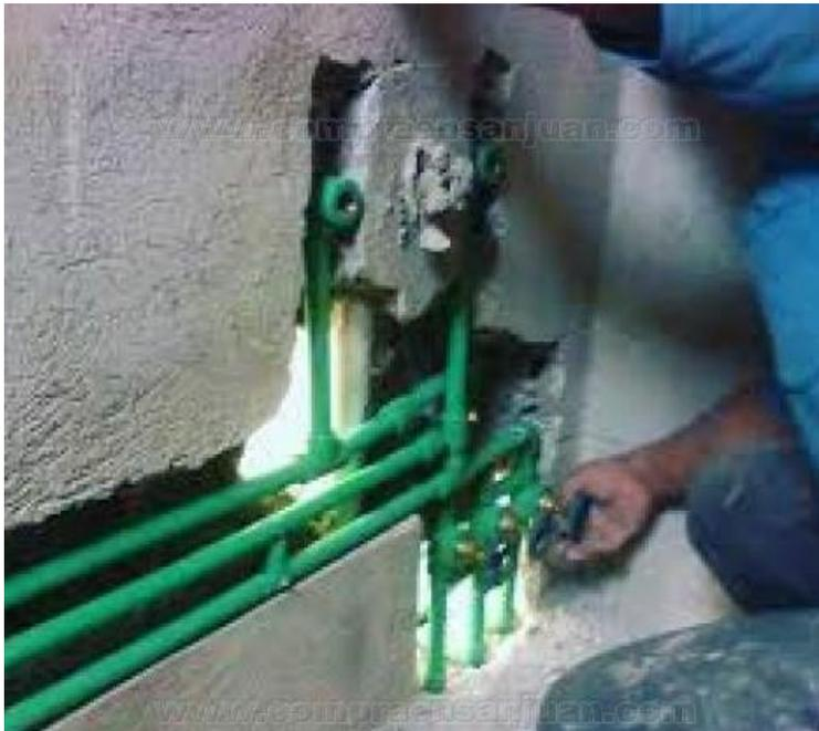
Imagen N°12 (Instalación de agua potable termo fusión)
