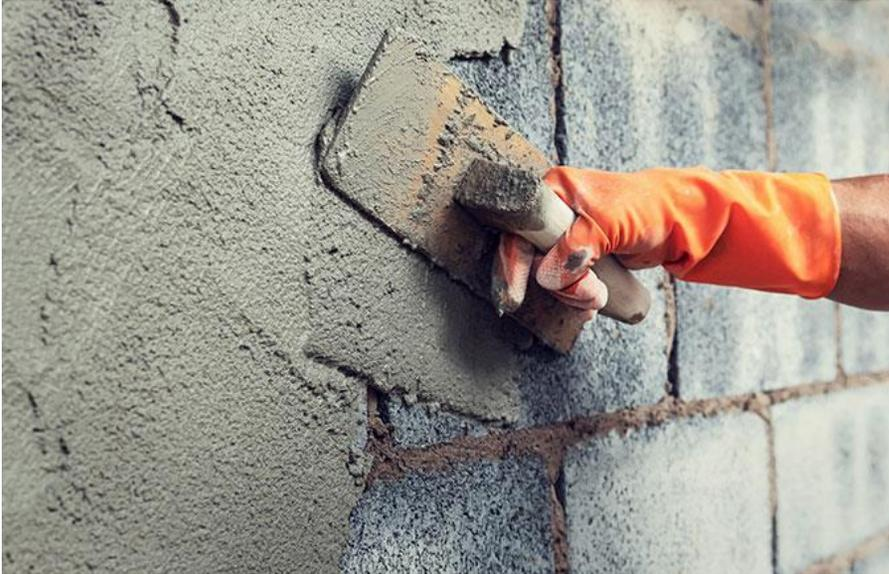
Imagen N°10 (Enlucido de paredes exteriores e interiores)
