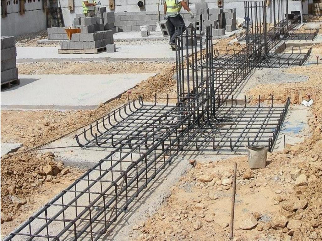
Imagen N°4 (Armadura de cimentación zapata corrida)
