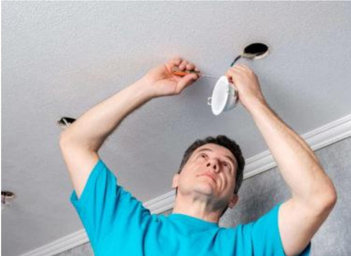
Imagen N°21 (Instalación de luminaria en tumbado)
