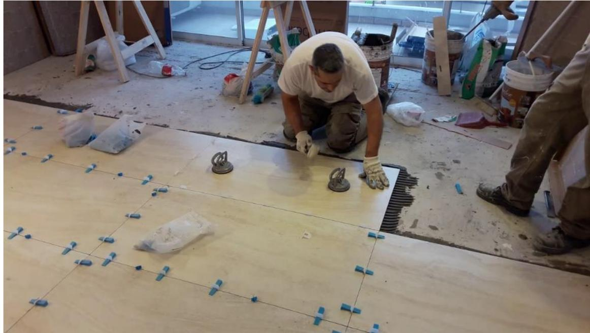
Imagen N°16 (Instalación de acabado de piso)
