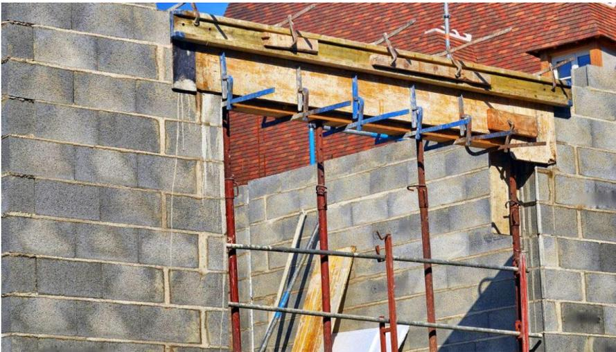
Imagen N°11 (Elaboración de dinteles para puertas y ventanas)
