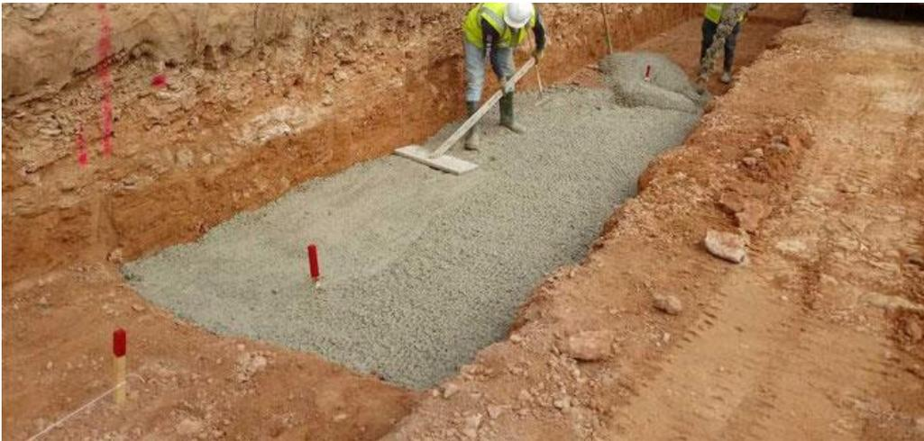
Imagen N°3 (Replanteo de hormigón simple  $e=0.10\text{m}$ )
