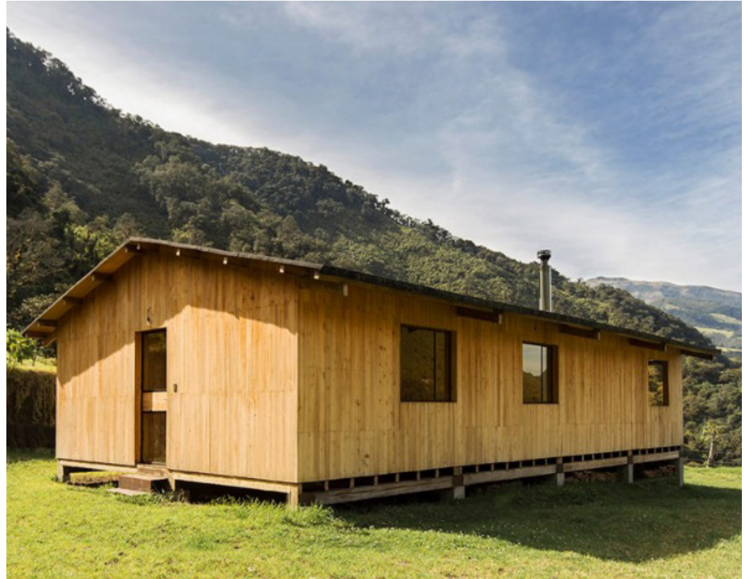
Imagen 76: Vivienda de eucalipto en la Sierra. Fuente: (Avatar Energía, 2019).
