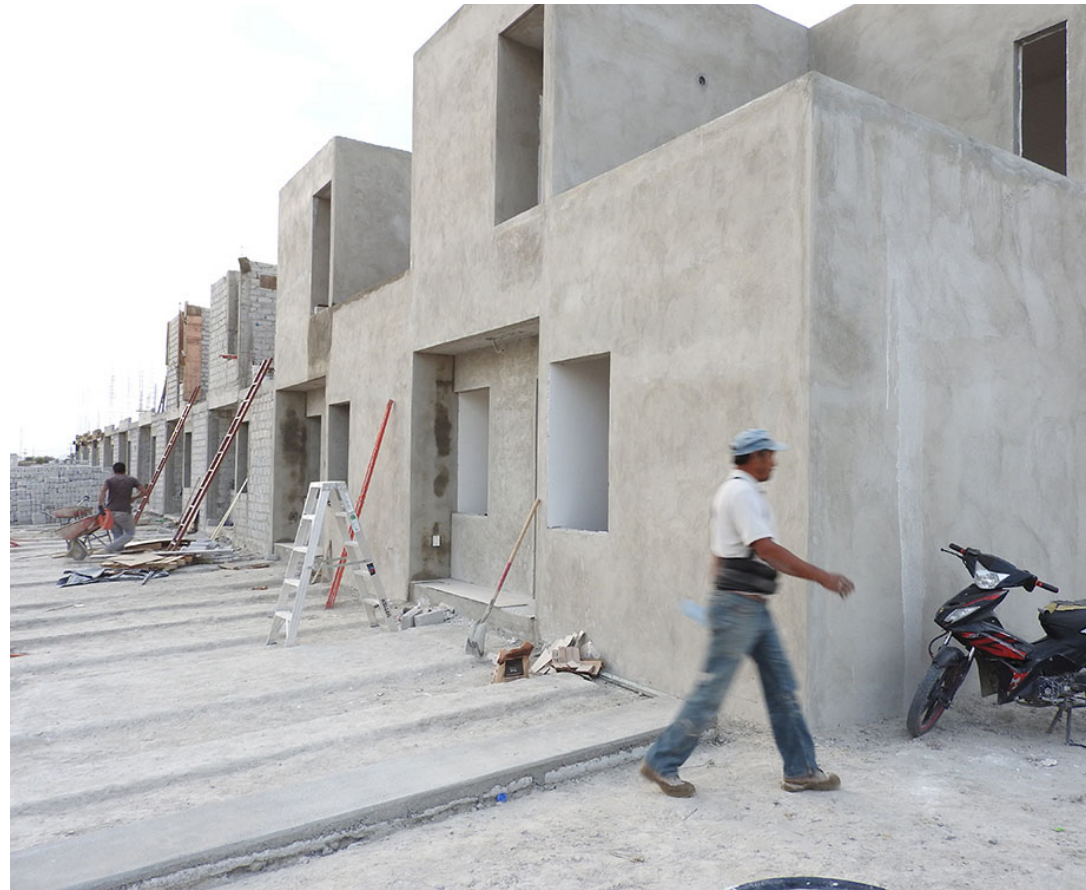
Imagen 63: Proceso constructivo. Fuente: (Plataforma Arquitectura, 2016).
