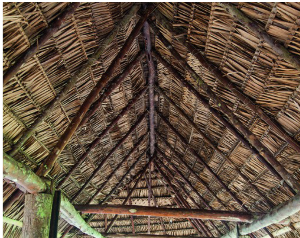
Imágen 74: Estructura de cubierta de bambú. Fuente: (Revista Clave, 2020).
