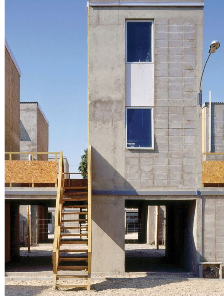
Imagen 19: Vivienda social ELEMENTAL por Alejandro Aravena. Fuente: (Plataforma Arquitectura, 2007).
