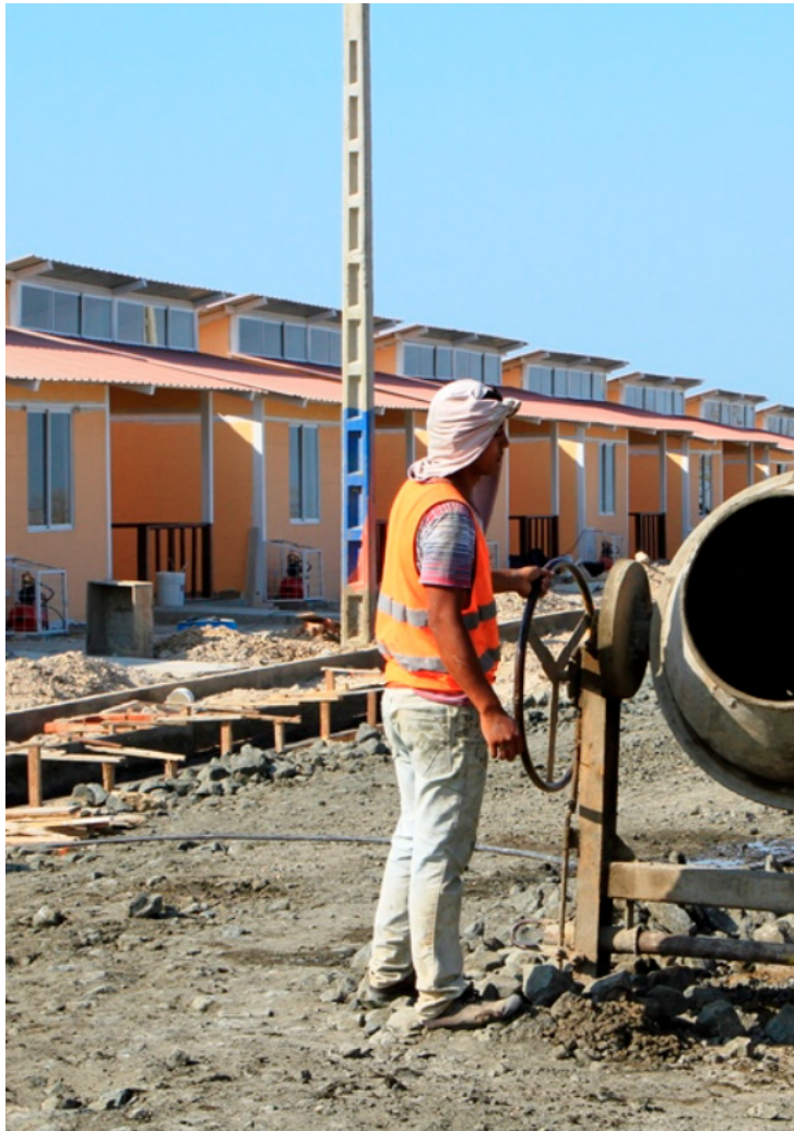
Imagen 43: Etapa de construcción. Fuente: (Revista de Manabí, 2016).
