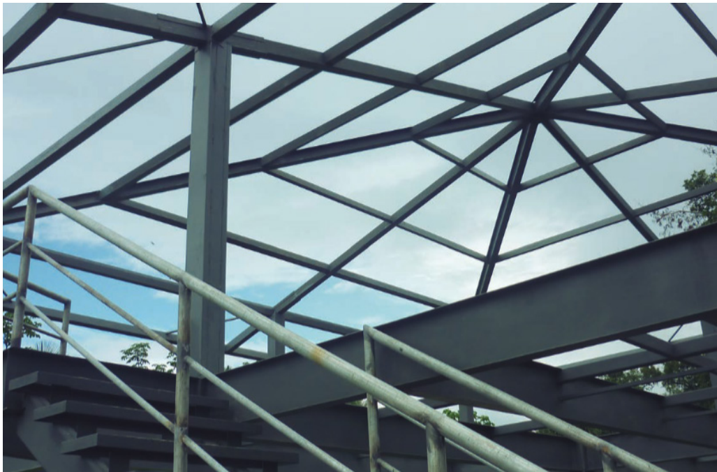
Imágen 49: Estructura metálica de la vivienda Fuente: (Comunidades del Milenio, 2012).
