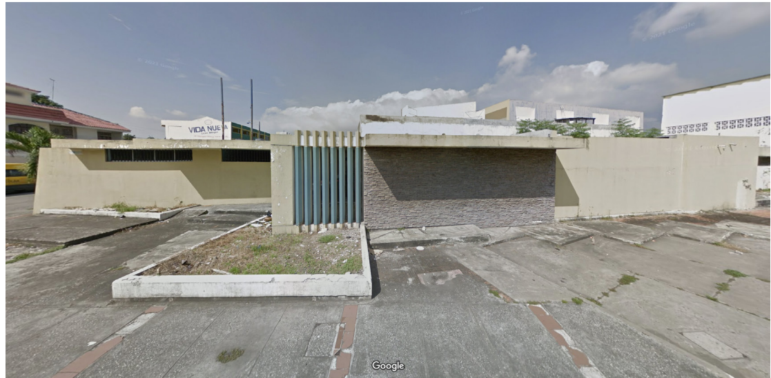
Imágen 31. Ubicación de terreno Fuente: Google Maps
