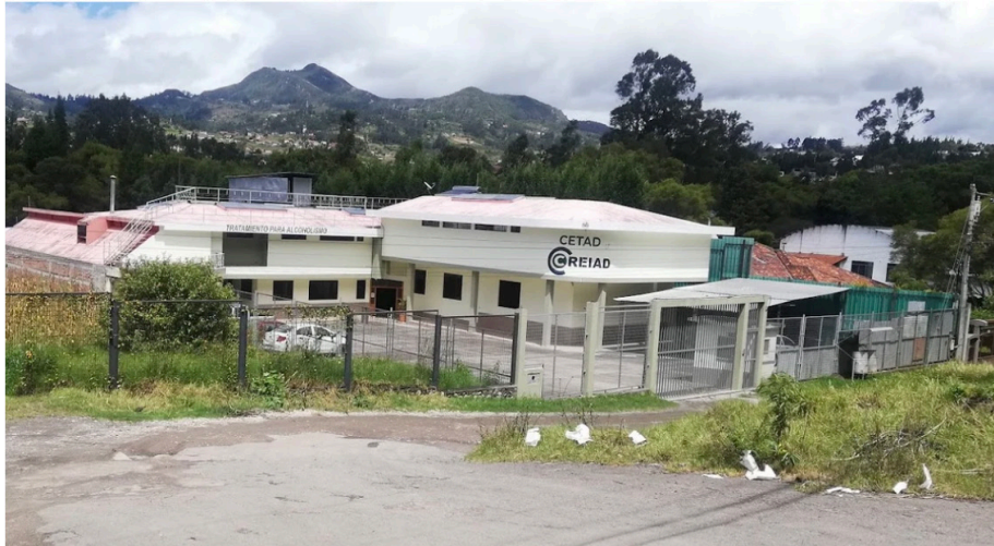
Figura 62. Materialidad del centro CREIAD. Fuente: Nicelocalec, 2019
