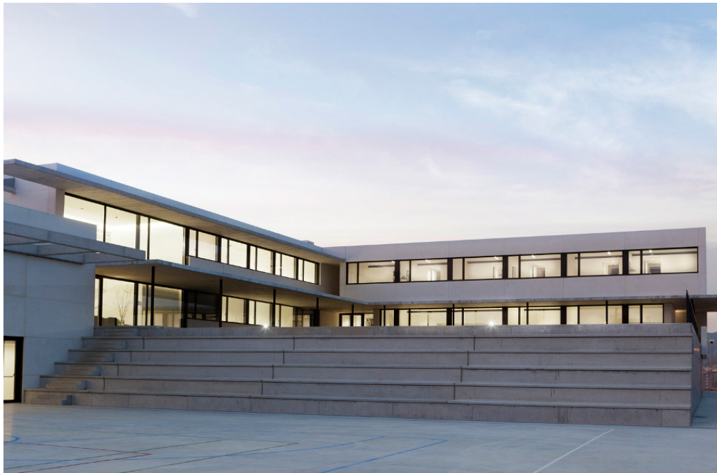
Figura 50. Proyecto Hombre Galicia, edificio principal. Fuente: Plataforma Arquitectura, 2014
