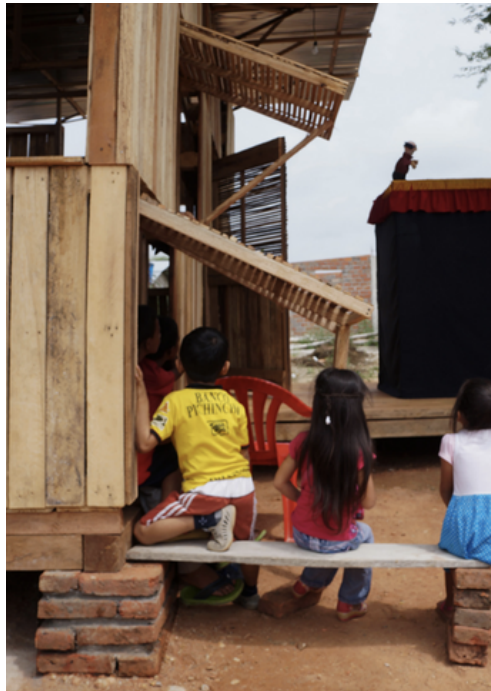
Imagen 45. Bases de hormigón. Fuente: Plataforma arquitectura, 2016
