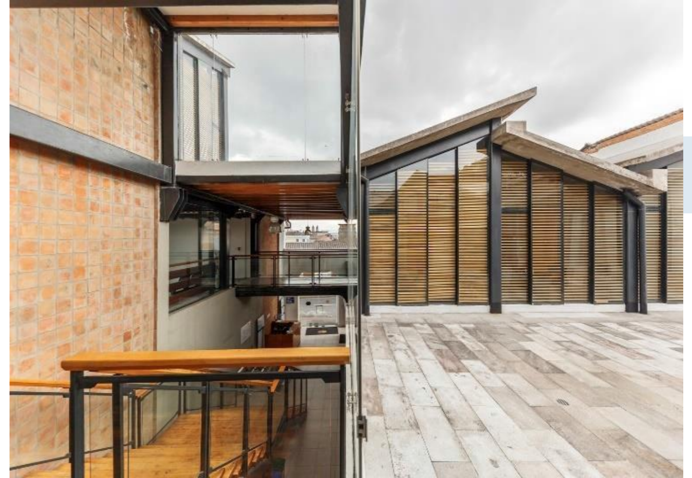
Imagen 13 Escalera y jardín exterior del Centro Ambulatorio de Salud Mental San
