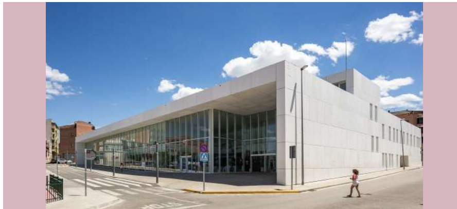
Figura 11 Sustracciones en fachadas Fuente: (Arqa ,2018)
