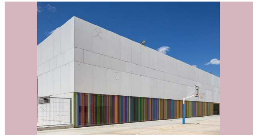
Figura 12 Fachada posterior Fuente: (Arqa ,2018)
