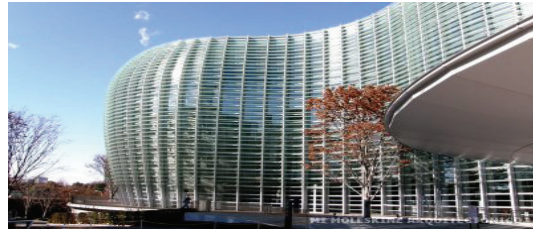
1.20 Foto Exterior . mimoleskinearquitectónico
