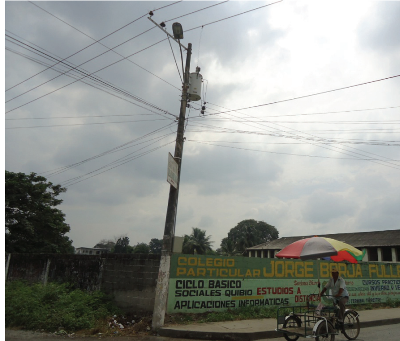
1.44 Visual desde el Sureste - Infraestructura
