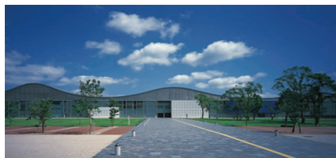
1.25 C. Arte Exterior. mimoleskinearquitectónico
