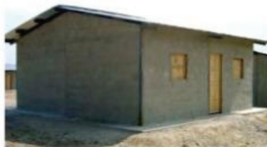
Casa de estructura metálica con paredes de bloque. 6.00 x 6.00mts
