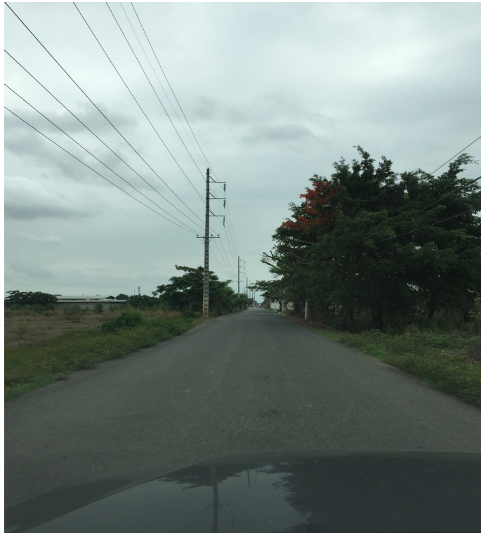
Imagen 46: Levantamiento fotográfico 1 Fuente: Elaboración propia
