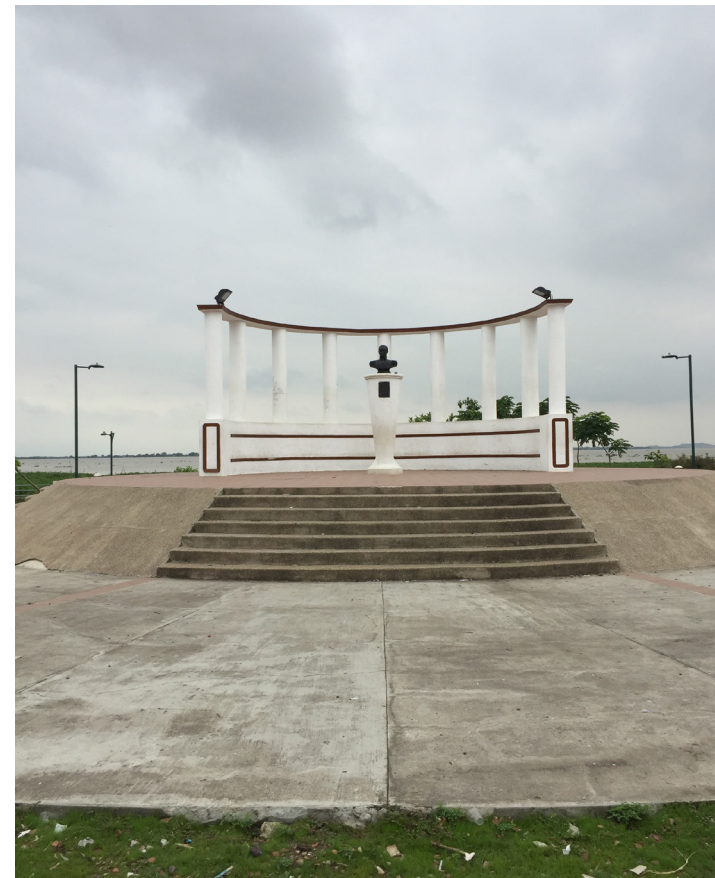
Imagen 59: Levantamiento fotográfico 14 Fuente: Elaboración propia
