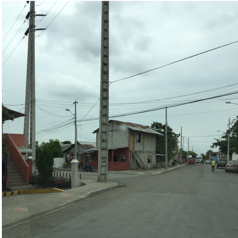
Imagen 48: Levantamiento fotográfico 3 Fuente: Elaboración propia
