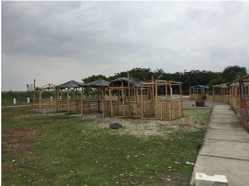
Imagen 60: Levantamiento fotográfico 15 Fuente: Elaboración propia
