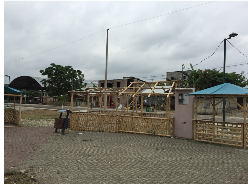
Imagen 61: Levantamiento fotográfico 16 Fuente: Elaboración propia
