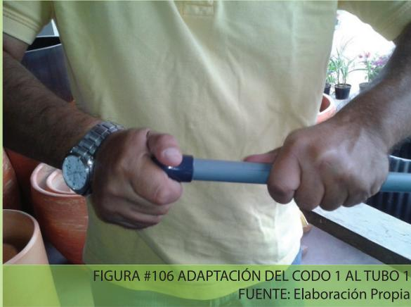
FIGURA #106 ADAPTACIÓN DEL CODO 1 AL TUBO 1
