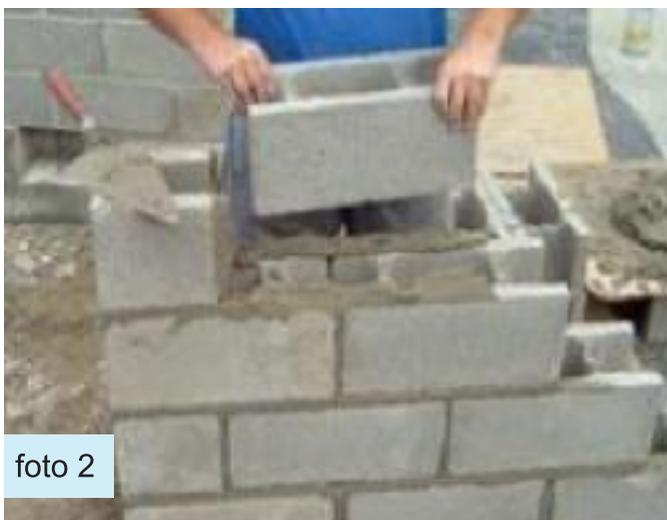
En la foto(2), puede observarse la instalación de uno de los bloques en la cuarta fila, note la utilización del medio bloque para alternar las filas y también como se ha colocado un cordón de mortero de unión en los bordes verticales del bloque contiguo al que se monta.
