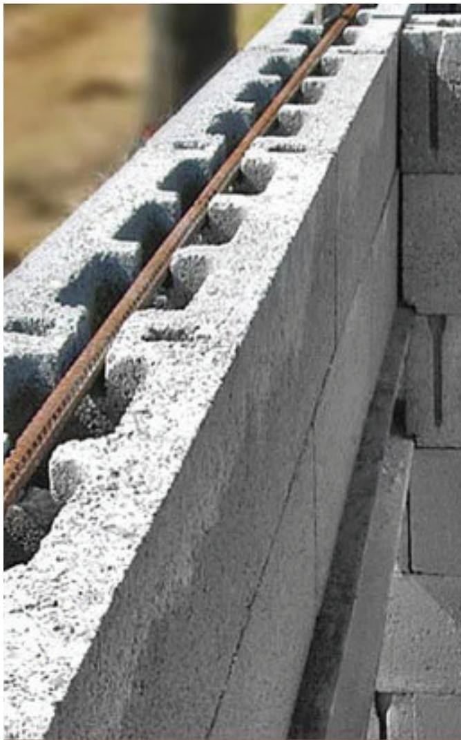
Para la construcción de bloques es necesario contar con la materia prima natural. Este material se consigue en los volcanes de la zona de la Sierra, se realiza la adquisición por metro cúbico. Luego de tener este material se lo mezcla con arena filtrada y cemento, a esta mezcla se le agrega agua hasta obtener una mezcla compacta y homogénea.
