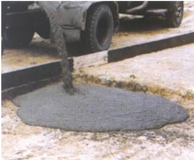
Ilustración 20: Inyección relleno fluido
