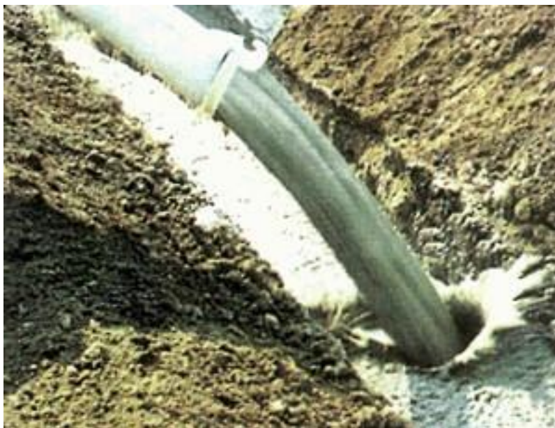
Ilustración 17: Relleno de zanja mediante mortero celular
