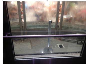
Imagen 83: Baranda de protección Fuente: Romero, G.(2015)
