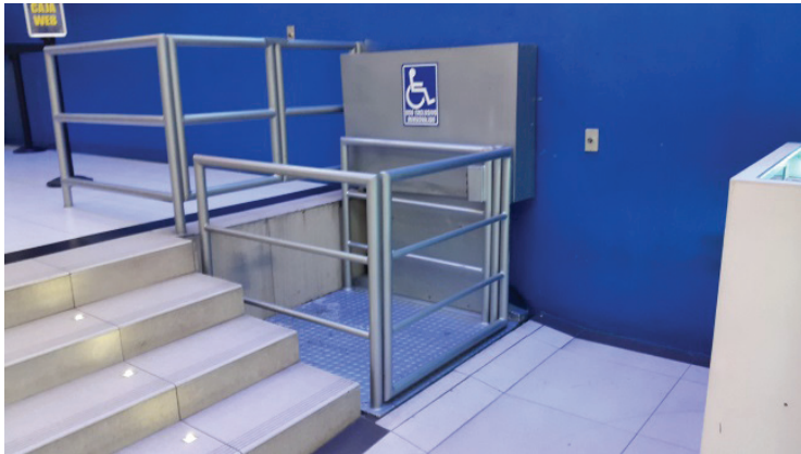
Imagen204: Plataforma elevadora de silla de ruedas de Riocentro Entreríos Fuente: Romero, G.(2015)
