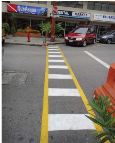
Imagen 24: Zona F conectan Rampa (5-7) Fuente: Romero, G. (2015)
