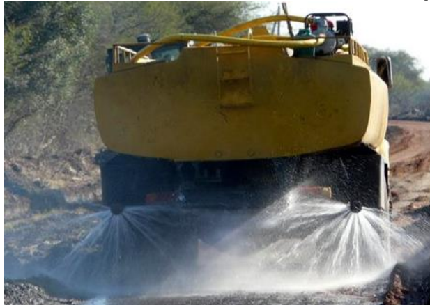
Gráfico 6 Vehículo estabilizador de suelo con químicos
