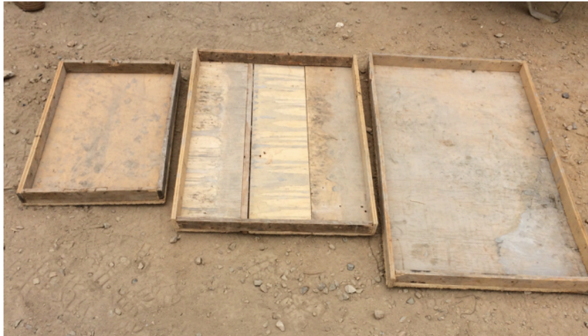
Figura #70 Encofrado De Plywood
