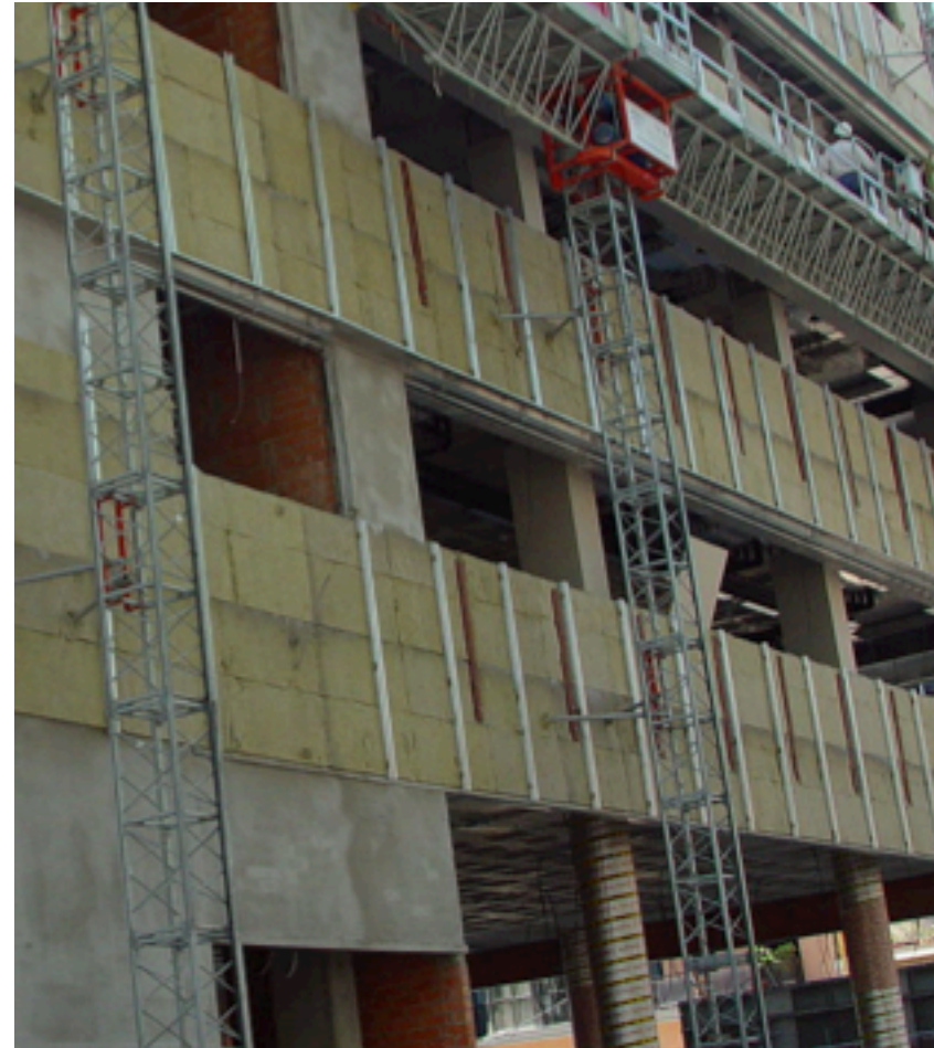
Figura #64 Estructuras Fachada
