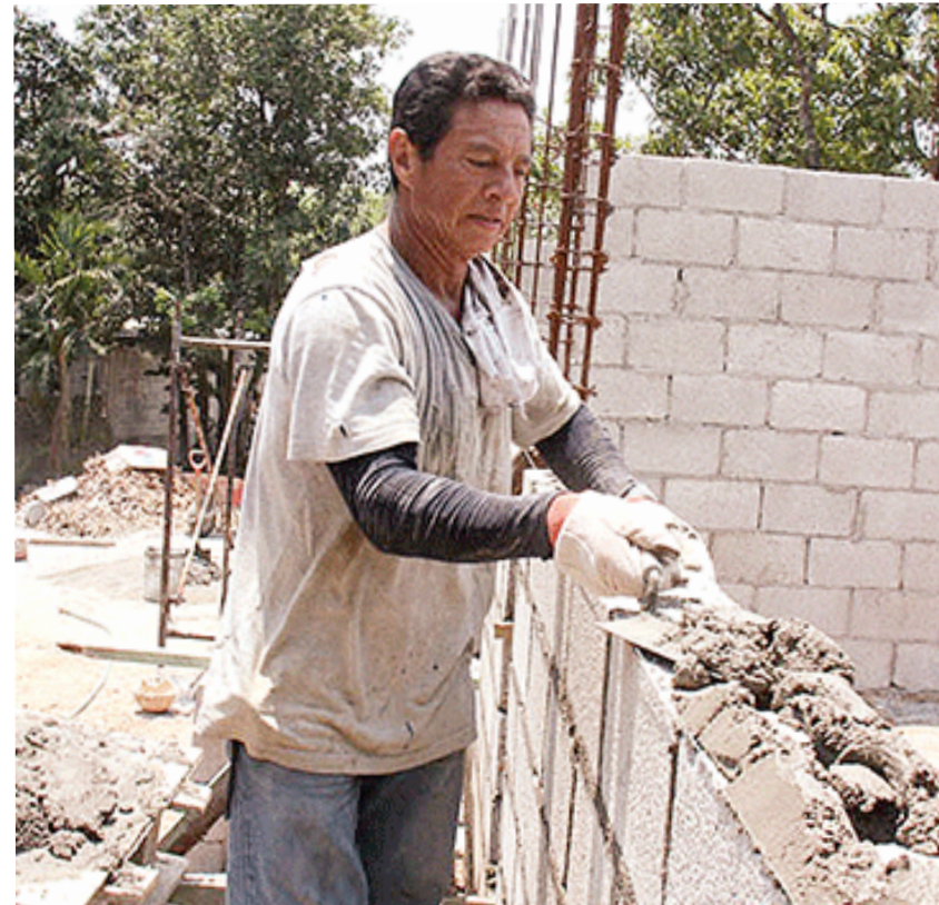
Figura #62 Proceso De Construcción
