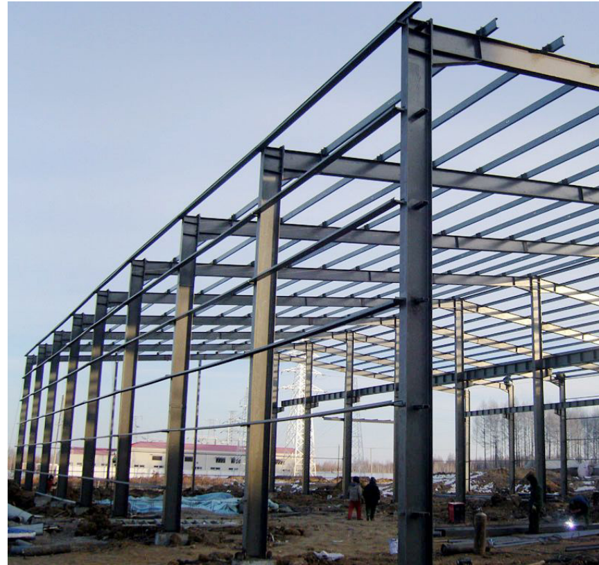
Figura #54 Prefabricado De Acero
