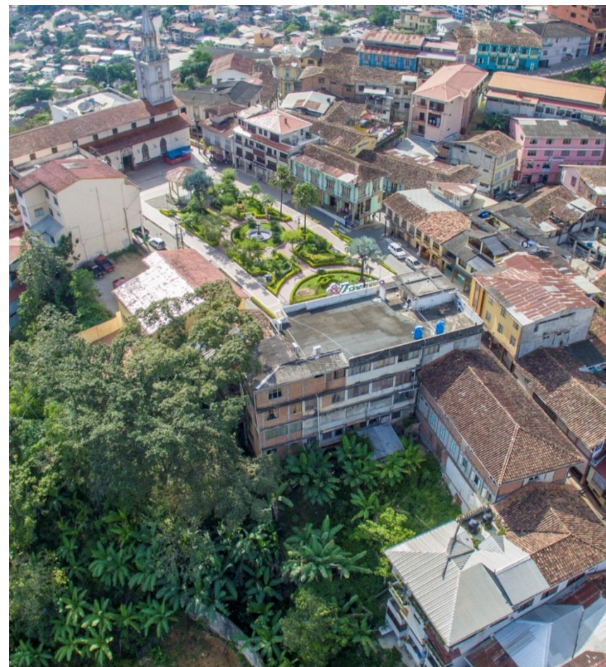
Imagen 4. Edificio GAD de Zaruma
