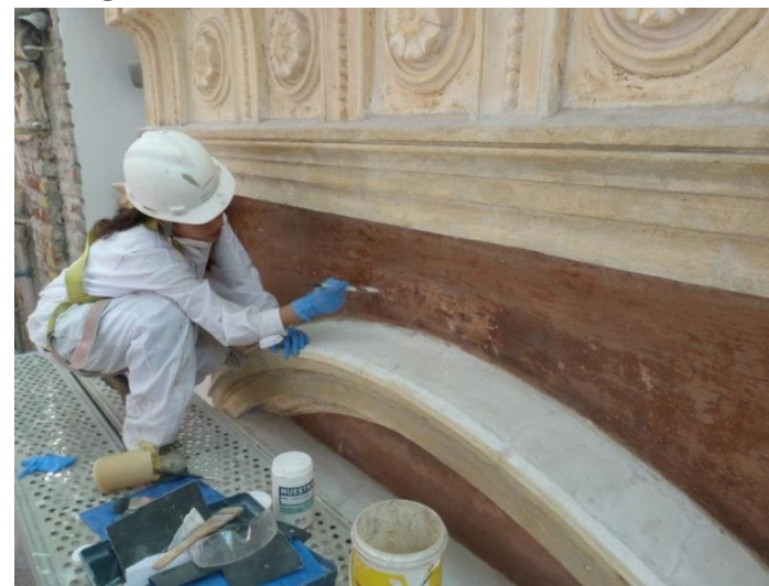
Imagen 17. Restauración de Edificio Patrimonial.
