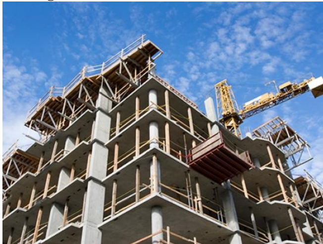
Imagen 15. Construcción de edificio
