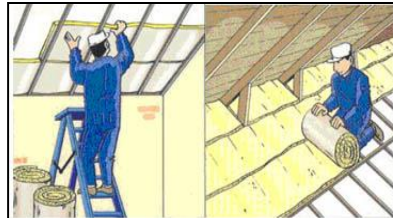
Figura No.39. Colocación de lana mineral Fuente.(Grupo Una Macor, 2011)
