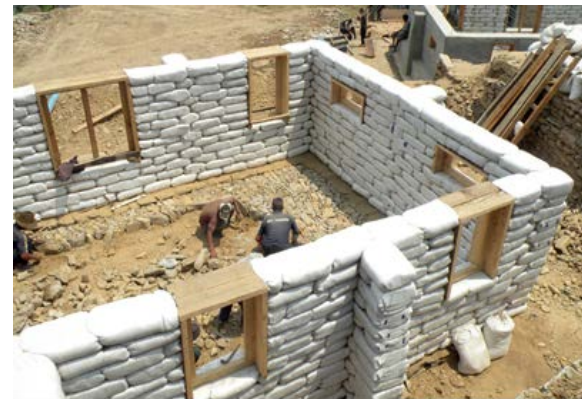
Ilustración 13: Proceso constructivo sistema earthbag.
