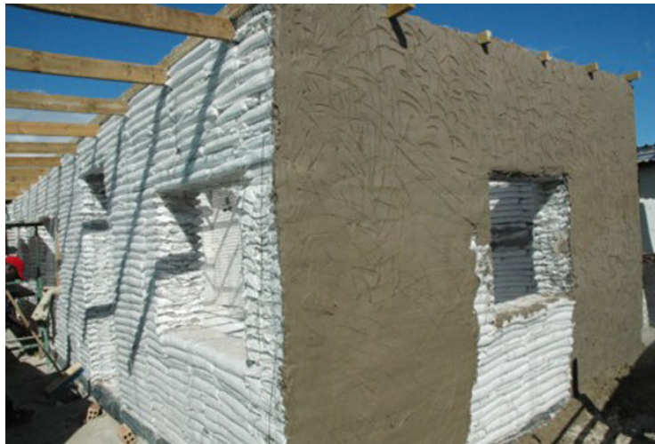
Ilustración 10: Proceso constructivo sistema earthbag.
