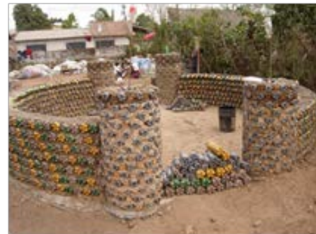
Ilustración 20: Proceso constructivo con los bloques Ecoladrillo.
