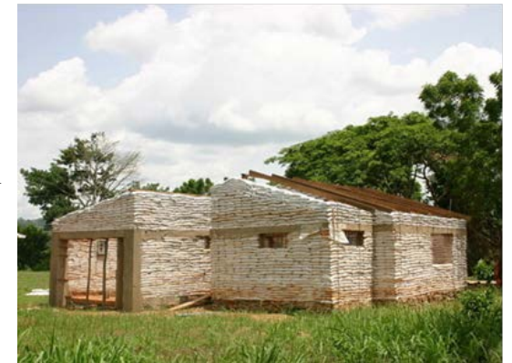
Ilustración 13: Proceso constructivo sistema earthbag.
