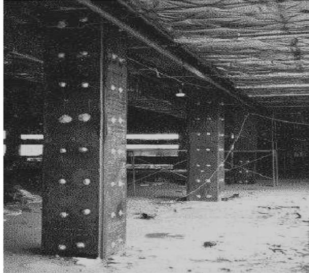
**Fig.13 Imagen de Columna con planchas de acero unidas. Fuente: (Sarmientos, 2003)**
