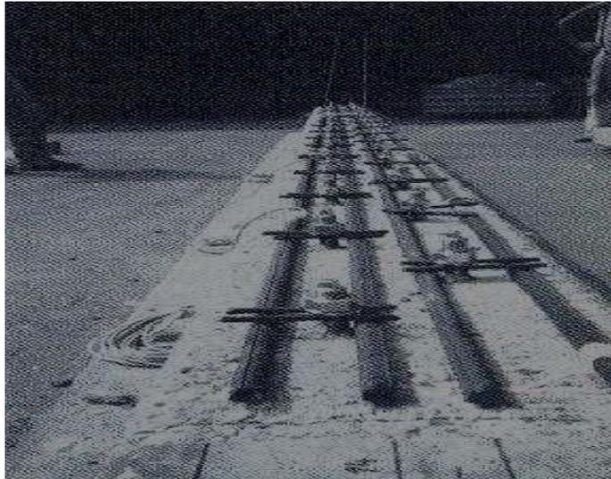
**Fig.16. Imagen de ubicación de acero de refuerzo longitudinal.
