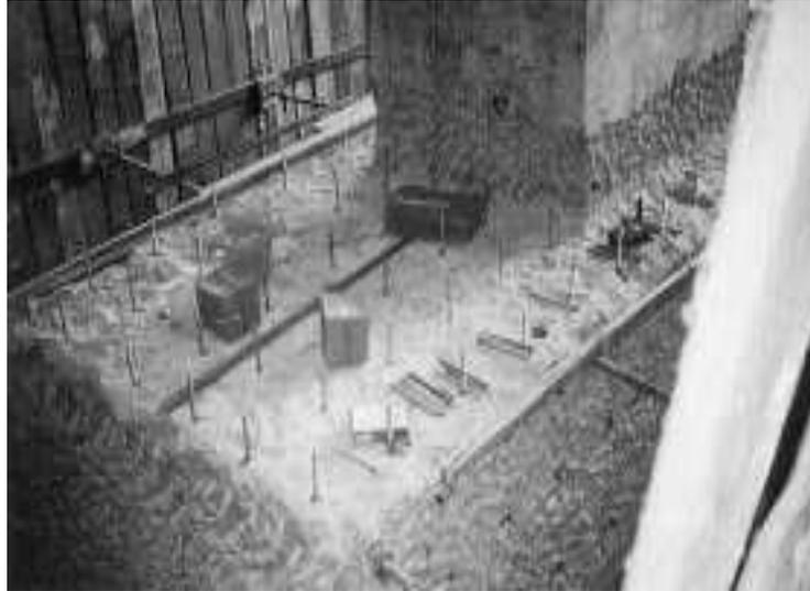
**Fig. 11 Imagen de preparación de cimentación para aumento de sección. Fuente:(Sarmientos, 2003)**
