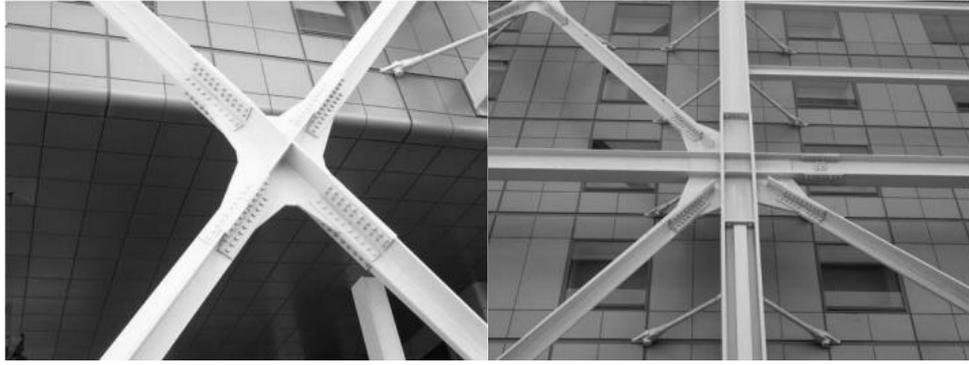
**Fig.14 Imagen de Edificio con arriostramiento diagonal exterior.
