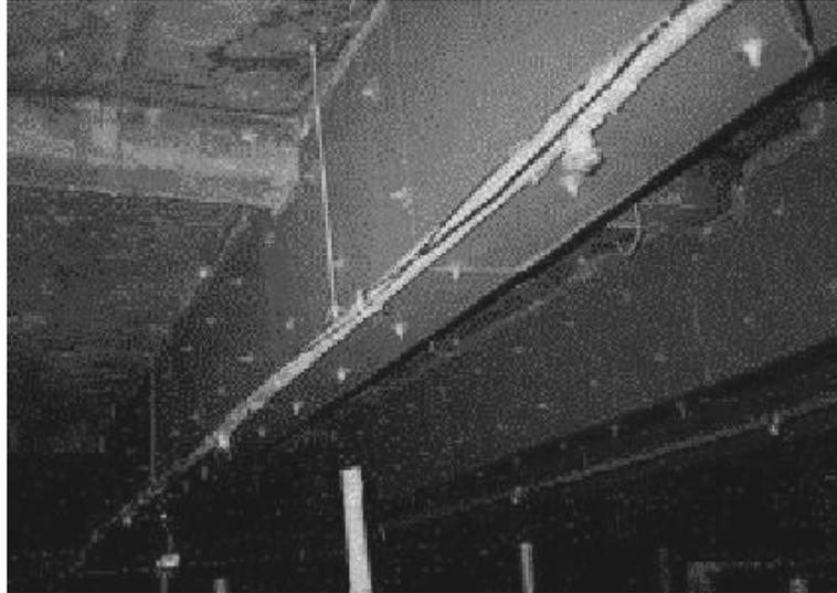
**Fig.17 Imagen de planchas de acero colocas en viga. Fuente: (Sarmientos, 2003)**
