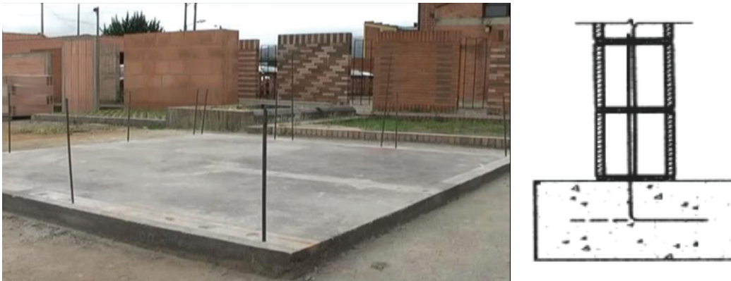
Figura 21. Anclaje de las barras de refuerzo
