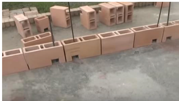
Figura 22. Colocación de la primera fila de bloques
