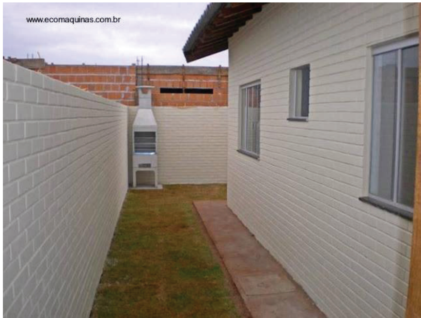
Figura 12. Muros exteriores con excelente terminación
