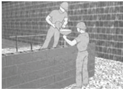
Figura 25. Inyección de celdas con embudo (izquierda) y con bomba (derecha)
