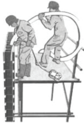
Figura 25. Inyección de celdas con embudo (izquierda) y con bomba (derecha)
