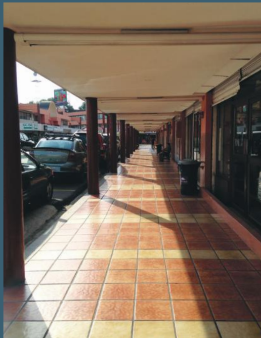
Imagen 13. Ejemplo de acceso interrumpido por muro de hormigón en locales comerciales del C. C. Plaza Quil. Fuente: Elaboración propia
