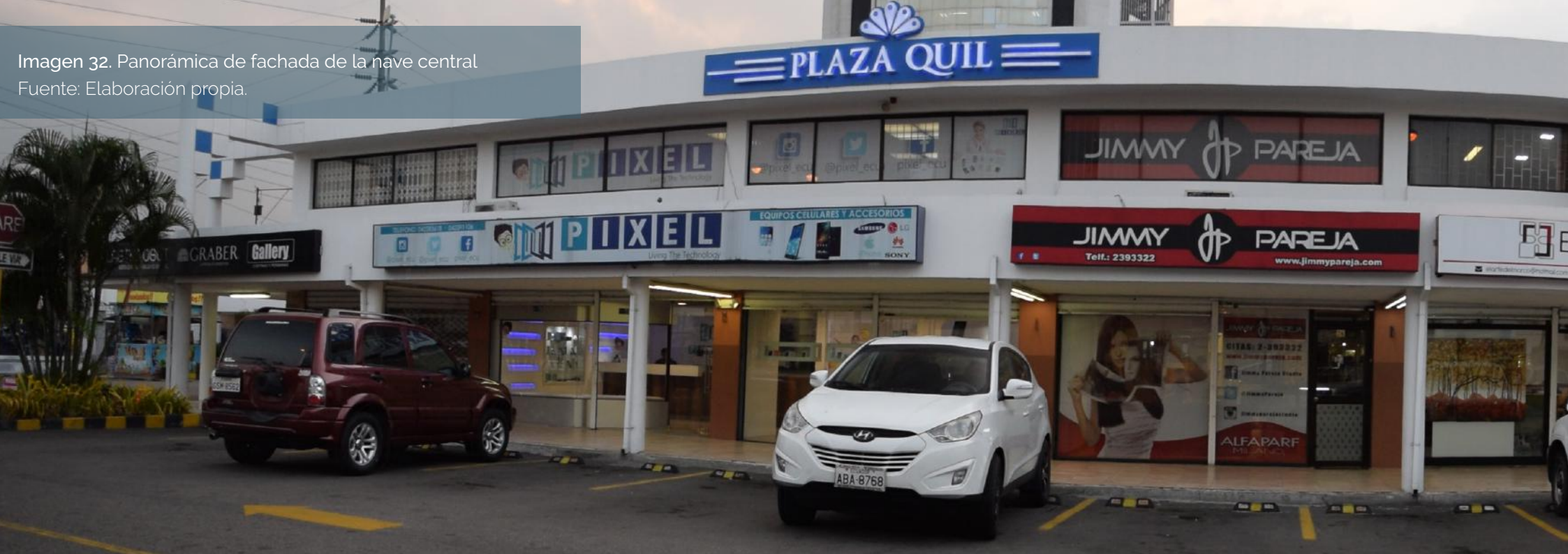
Imagen 33. Panorámica de fachada nave central (vista hacia KFC) Fuente: Elaboración propia.
