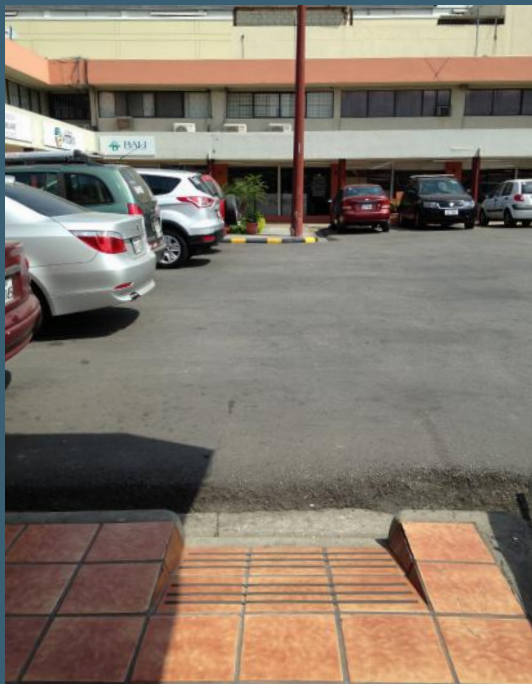
Imagen 12. Ejemplo de rampa de acceso en uno de los volúmenes del C.C. Plaza Quil. Fuente: Elaboración propia
