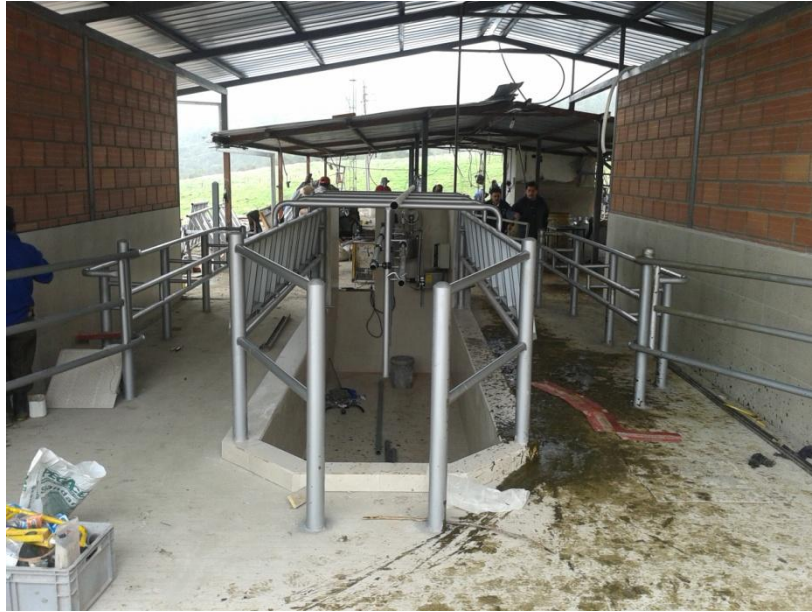
Figura 5. Colocación de las puertas
