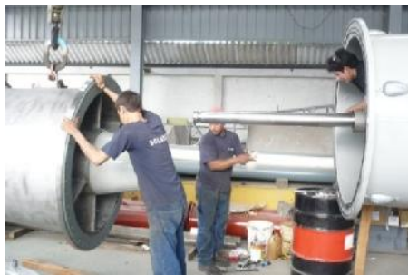
Imagen 5. Proceso de ensamble de campana y cuerpo de bomba.
