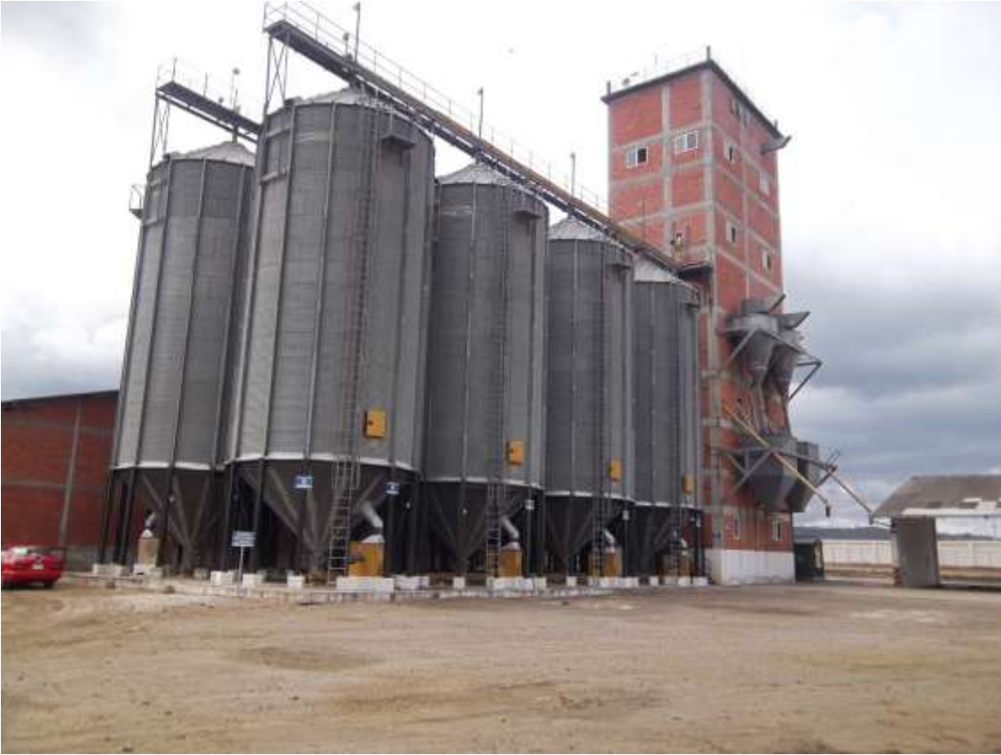
SILOS DE LA PLANTA DE DAULE, CON CAPACIDAD DE ALMACENAMIENTO PARA ARROZ, MAIZ Y SOYA, CON FRECUENCIA SE ALMACENA ARROZ.
